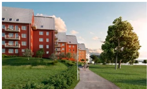
Visionskiss Igelsta strand och Korpudsparken, Viksängen. Flerbostadshuset är i byggnationsfas
