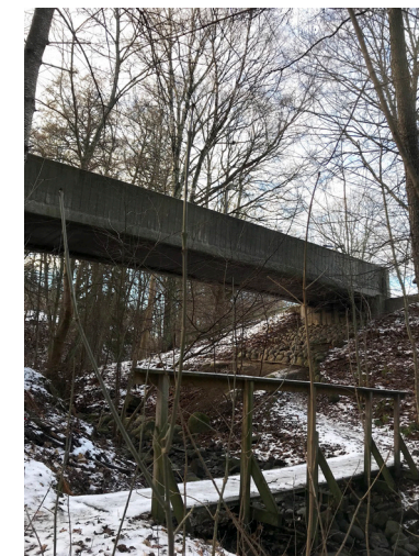
Betongbron över ravinen vid Fribovägen.
