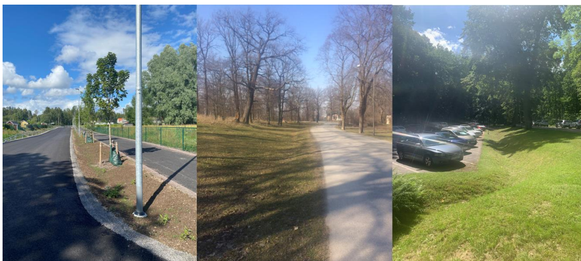
Figur 14. Exempelbilder på skålade grönytor som både kan anläggas med och utan träd, samt med och utan underliggande skelettjord. Foto: Bjerking.
