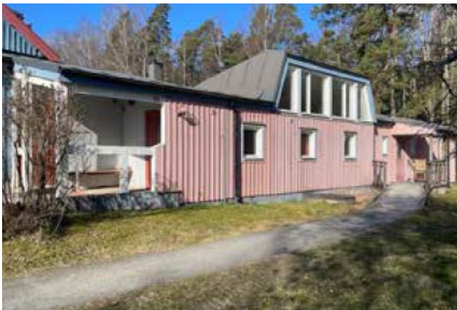
Vävstugan ritad av arkitekt Erik Asmussen.
