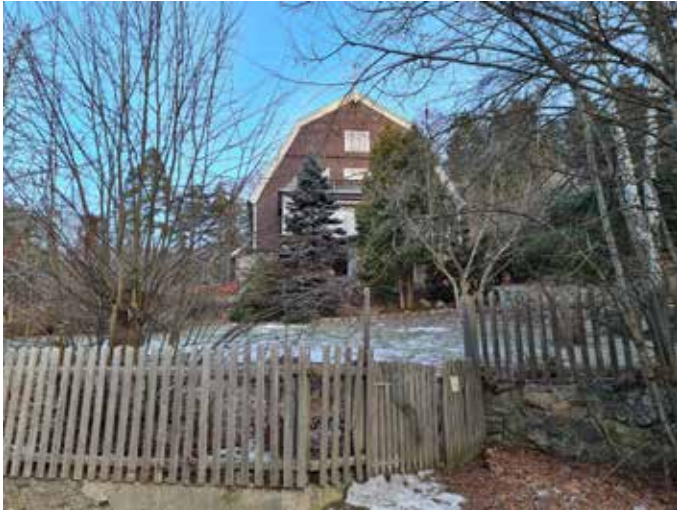
Villa Gulliborg från Nynäsvägen.
