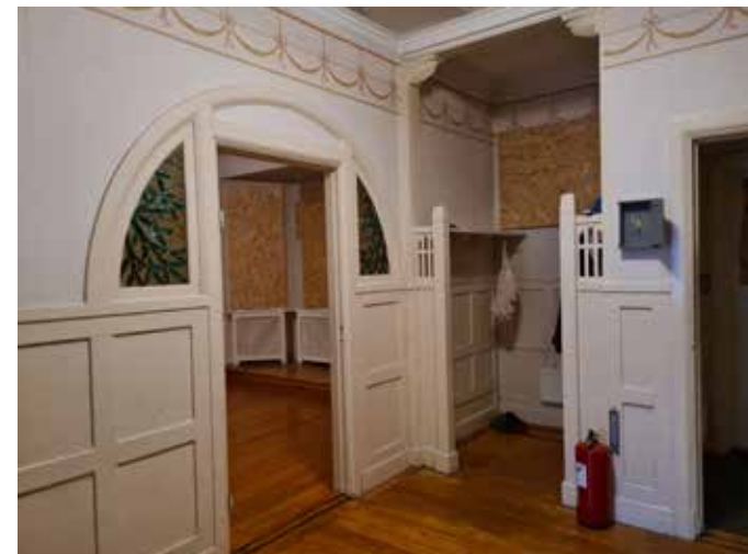
Entréhallen med välbevarad fast originalinredning i form av kapprum avskärmat med halvhöga skärmar som ansluter till den höga bröstpan-elen.
