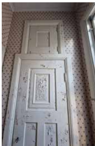
Skafteri i smatt mot källaren.
