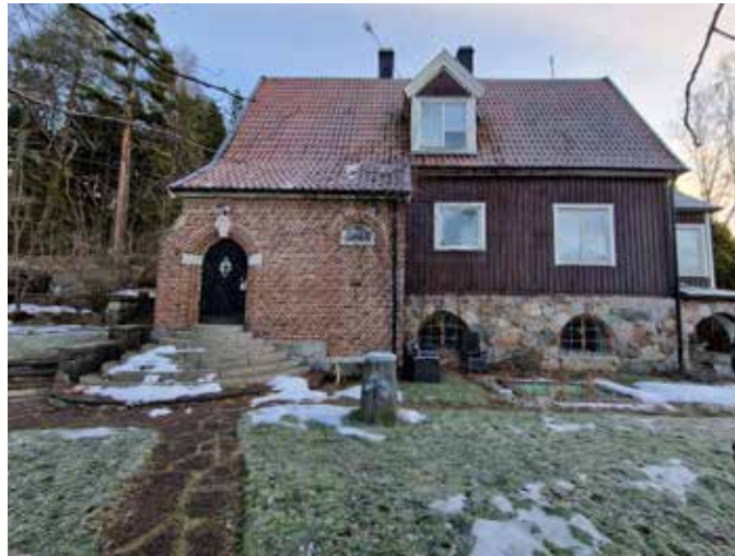
Villa Gulliborgs från väster med utskjutande, tegelomfattad huvudentré och kraftig naturstenssockel som inhyser en välvd pelargång längs med sydfasaden.
