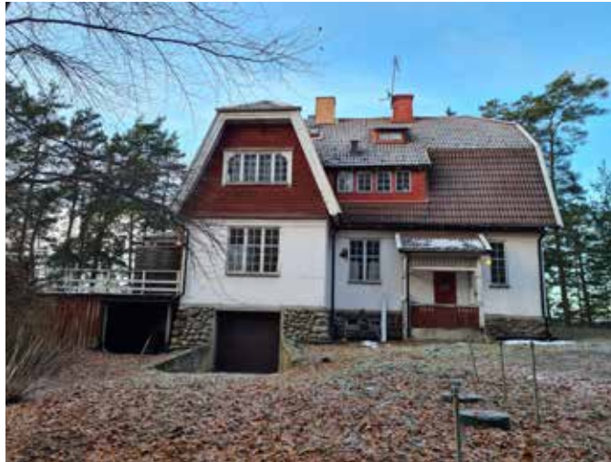
Villa Talludden är tidstypiskt formgiven i tidens nationalromantiska anda med ett varierat fasaduttryck med rik detaljeringsgrad.
