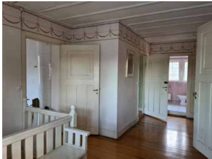
Övervåningens rum och inredning är till stor del intakt avseende kakelugnar, golv, snickerier och dörrar.
