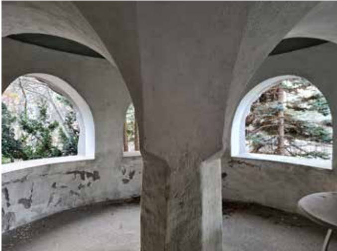
Den välvda terrassens pelargång med central sexkantig valvpelare.
