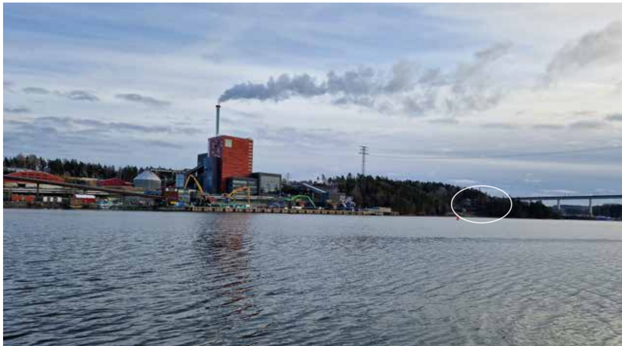
Igelstaverket och utredningsområdet med två villor, inringat, ligger invid Igelstaviken som utgör farleden in till Södertälje hamn.
