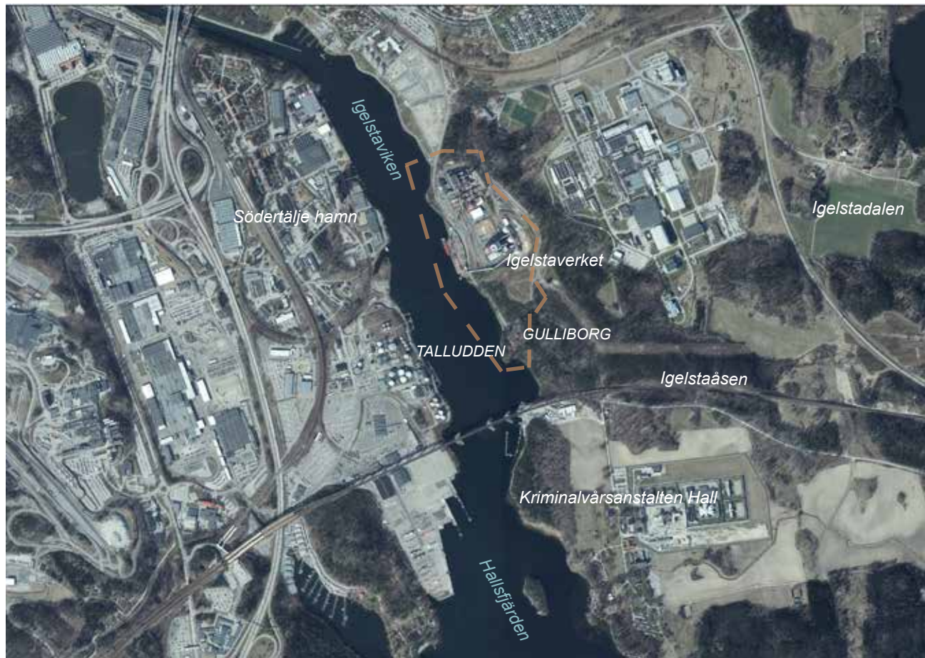
Planområdet ligger sydöst om Södertälje i anslutning till Igelstavikens östra kuststräcka. De aktuella villamiljöerna Talludden och Gulleborg ligger i planområdets södra del. Ortofoto. Södertälje kommun.
