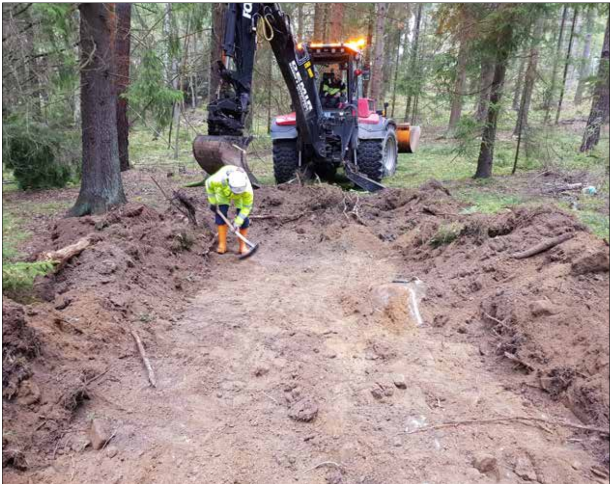
Figur 3. Schakt S210 under rensning, från söder.
