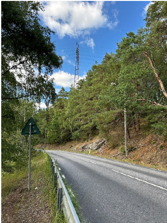
Figur 5. Bilden visar Nynäsvägen och slänten där berg syns i dagen.
