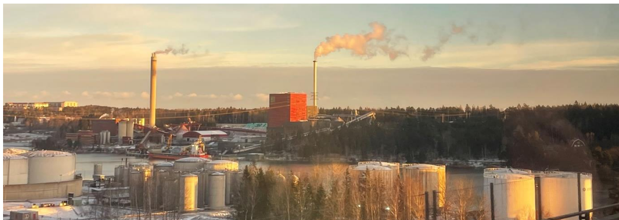
Figur 2. Igelstaverket med föreslaget utvecklingsområde till höger. Oljehamnen och farleden i förgrunden. Bild från Igelstabron. IGV beläget vid vänstra (norra) skorstenen och IKV1 beläget vid högra (södra) skorstenen. Foto: Oskar Pihl.
