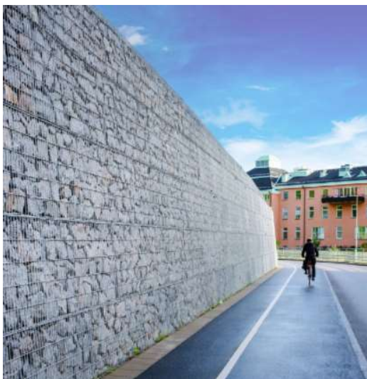
Bild 20: Exempel på gabionmur
