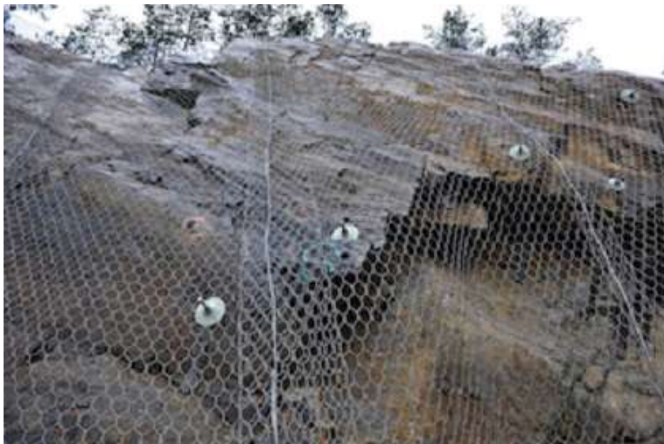
Bild 19: Exempel på bultförstärkning i kombination med stål nät i bergslänten
