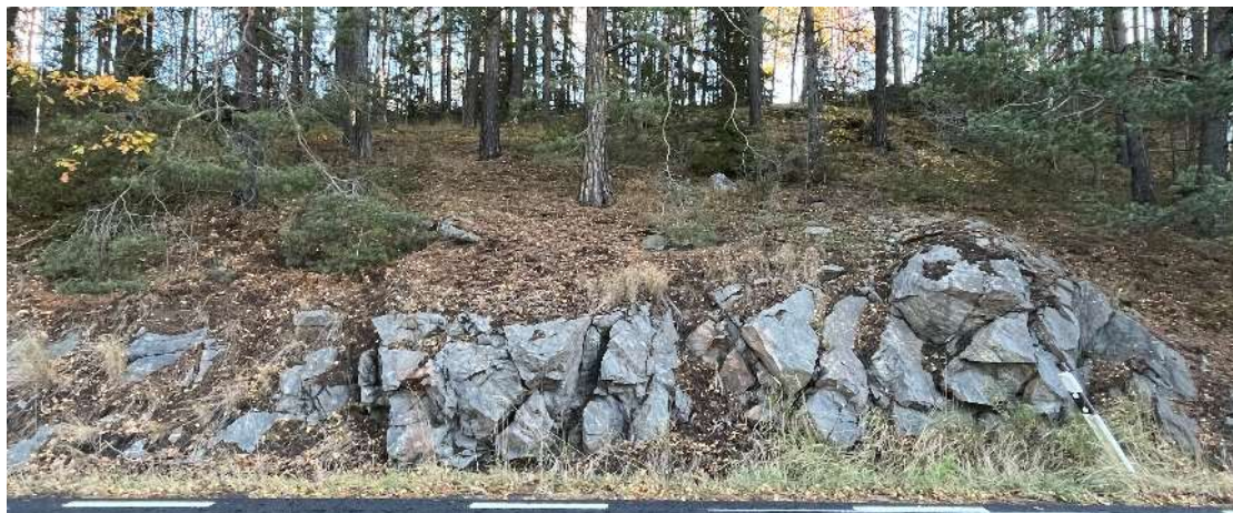
Bild 7: Bergsslänt nära Nynäsvägen
