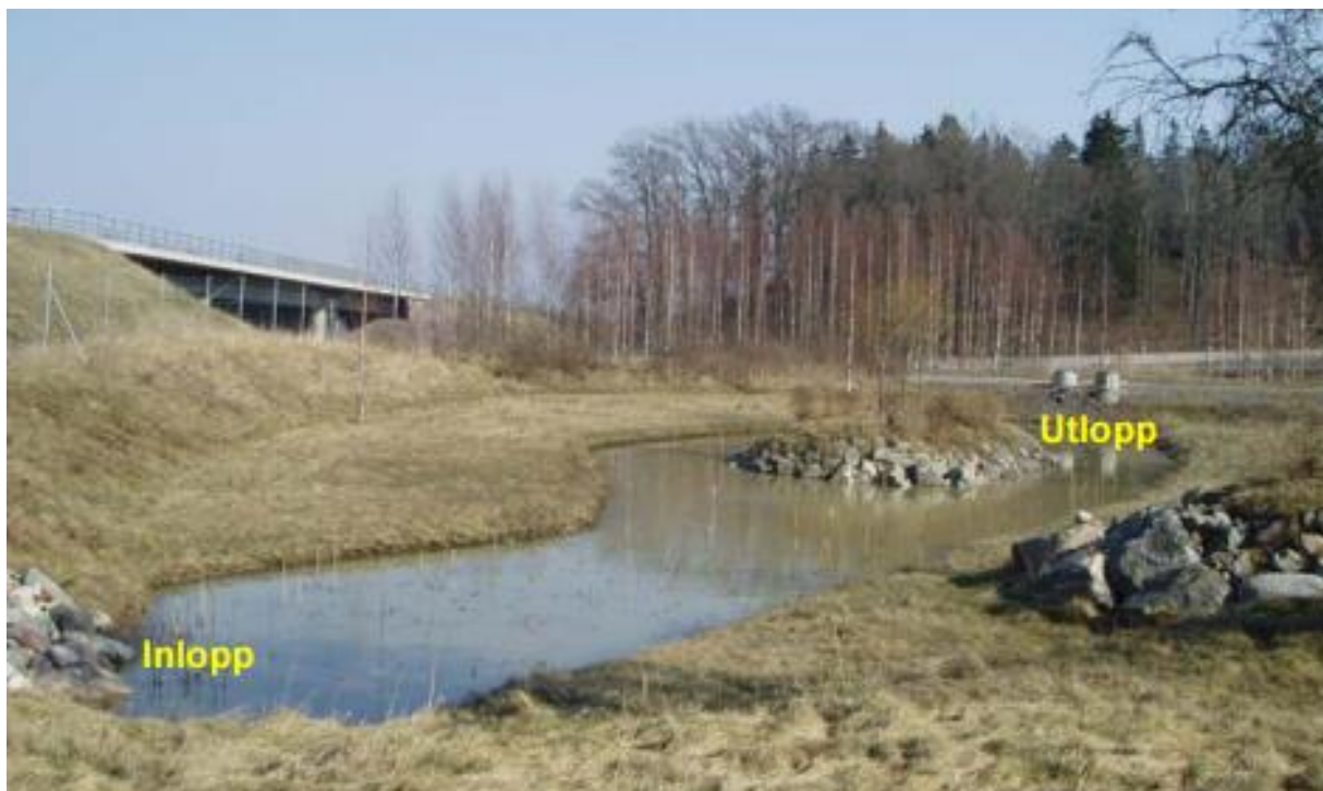
Figur 14. Exempel på "hinder" för att förlänga uppehållstid för vattenmolekyler. Källa: VV Publikation 2008:30.
