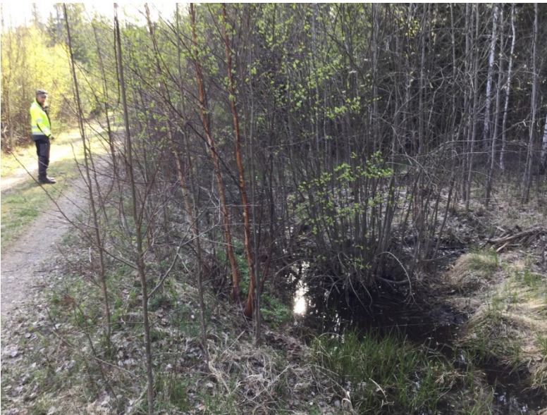
Figur 19. Mindre vattenfyllt dike utmed skogsväg.
