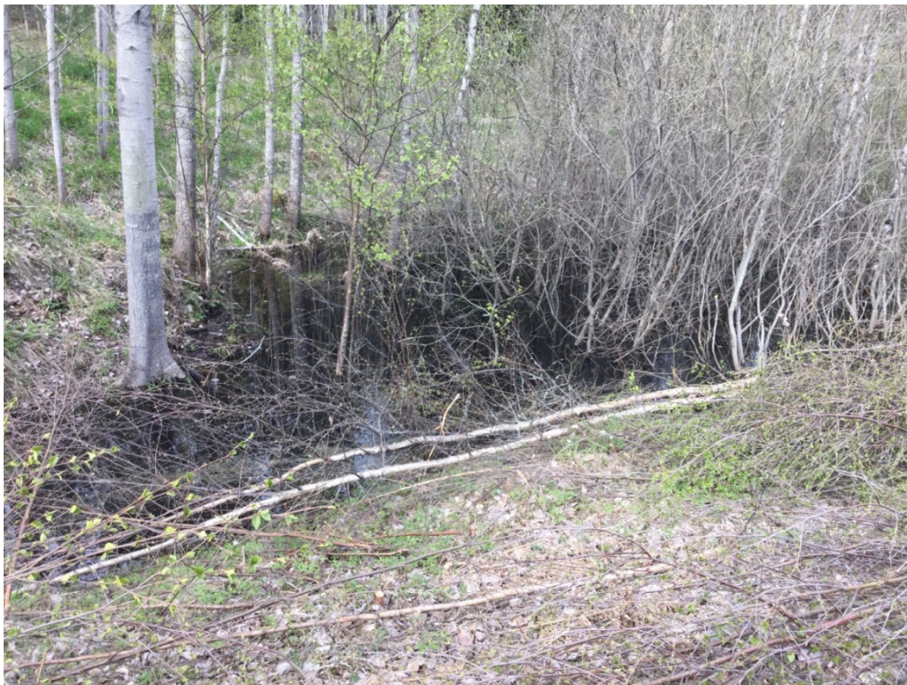
Figur 26. Vattenfylld yta norr om asfaltsvägen.
