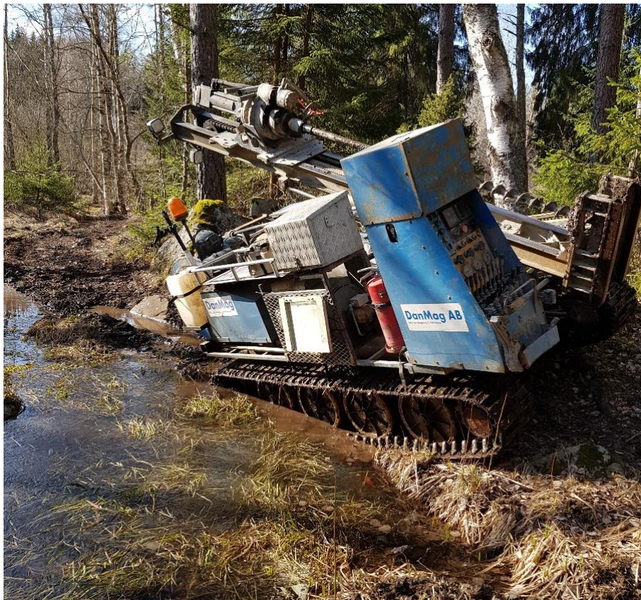
Bild 4. DanMag utförde flertalet försök att ta sig fram till provpunkterna PE19_J12 och J13 men på grund av den svåra trängen med vattensjuk och mjuk mark fick prover uttas med hjälp av handspade vid dessa provpunkter.
