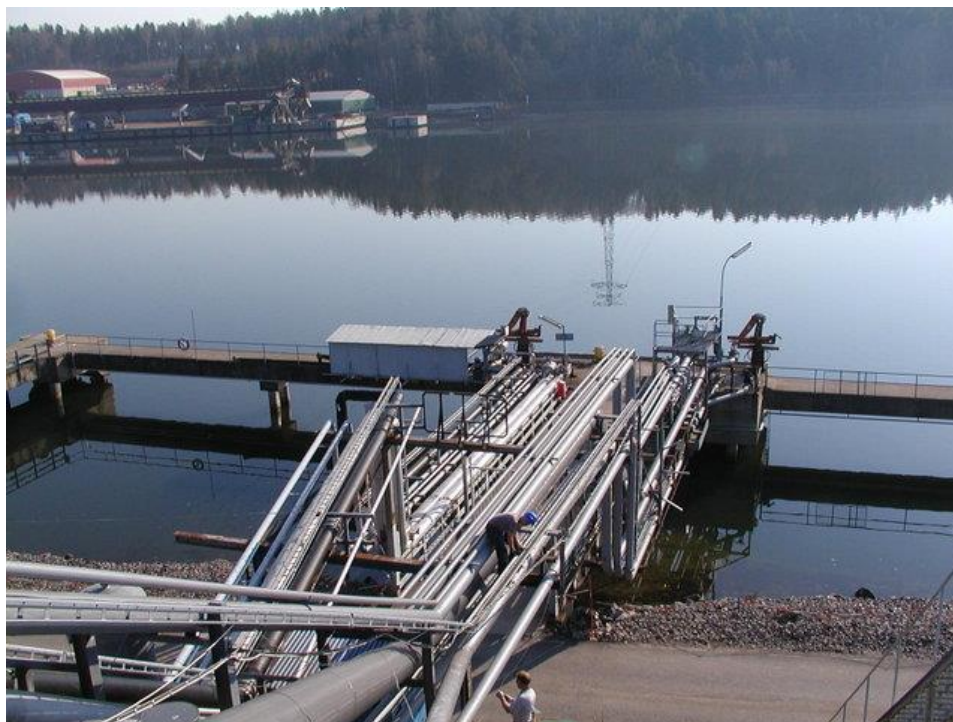
Figur 2. Överblick över kaj 6 inklusive ledningsgata med anslutande ledningar.
