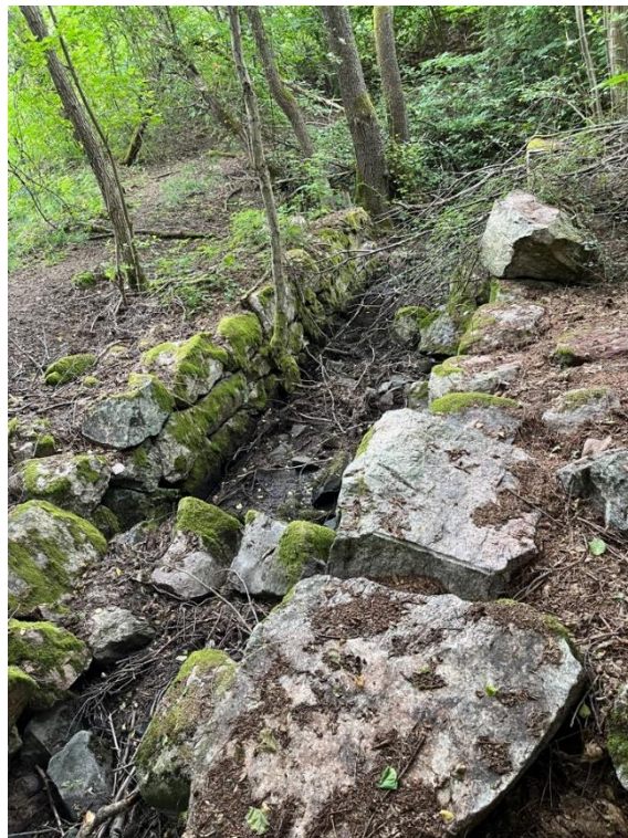
Figur 54 murarna till vattenrännan är kvar
