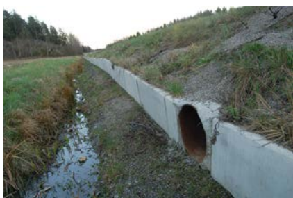
Figur 51. Exempel på en grodtunnel. För att leda groddjuren till tunneln behöver det finnas en barriär som hindrar dem från att korsa vägen. Foto Ekologigruppen.
