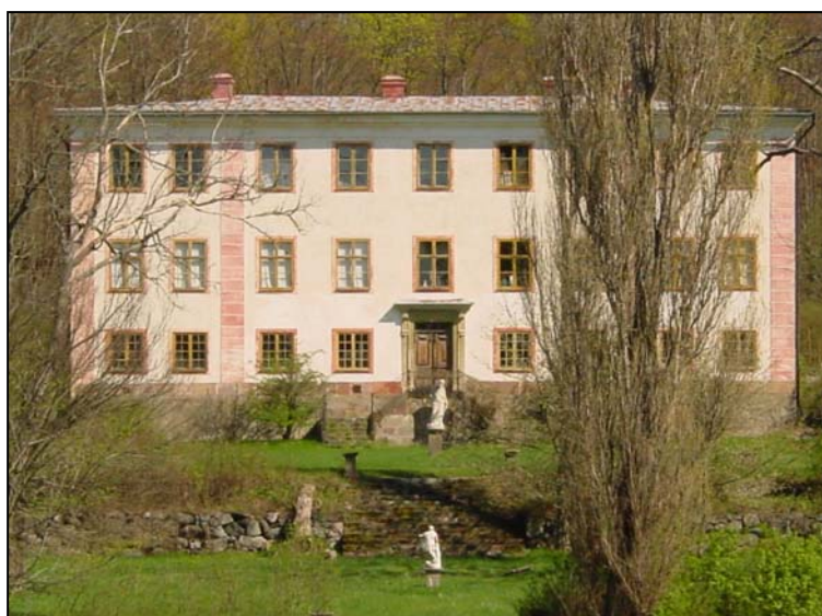
Huvudbyggnadens västra fasad och trädgård.
