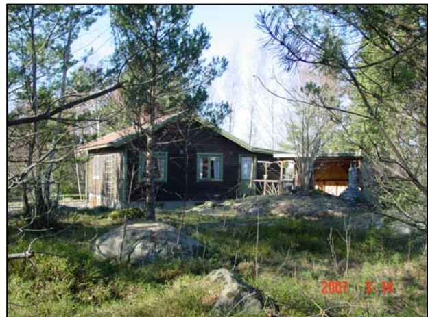
Fritidshus med dov färgsättning från 1900-talets mitt.
