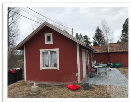
Figur 31 Komplementbyggnader med miljöskapande värden på Väsby 1:26
