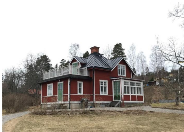
Figur 95 Gott exempel på tillbyggnad av sekelskifteshus. Foto: Anna Fredrikson
