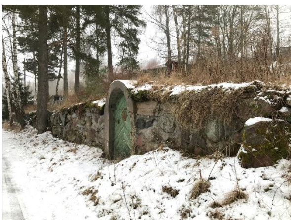
Figur 171 Mur med port
