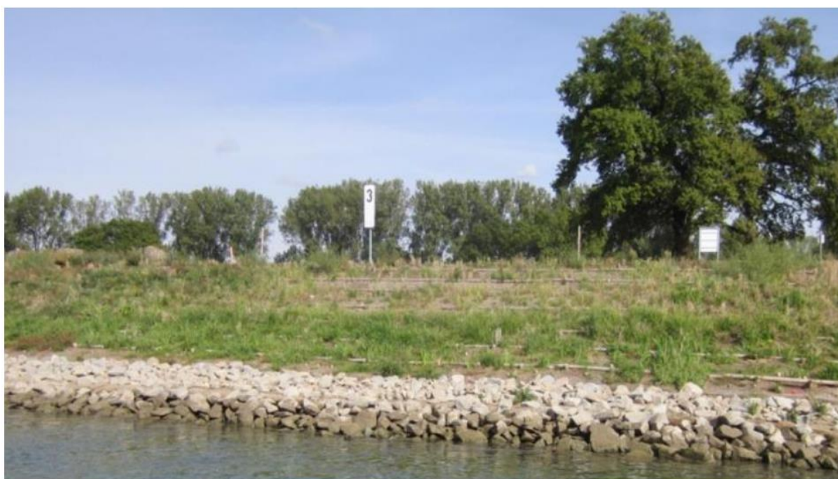
Figur 7. Kombinerat erosionsskydd med stenskoning och växter (SGI, 2016).
