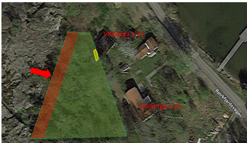
Bild 23: Område med löst bergblock i brant slänt – röd pil = fallriktning
