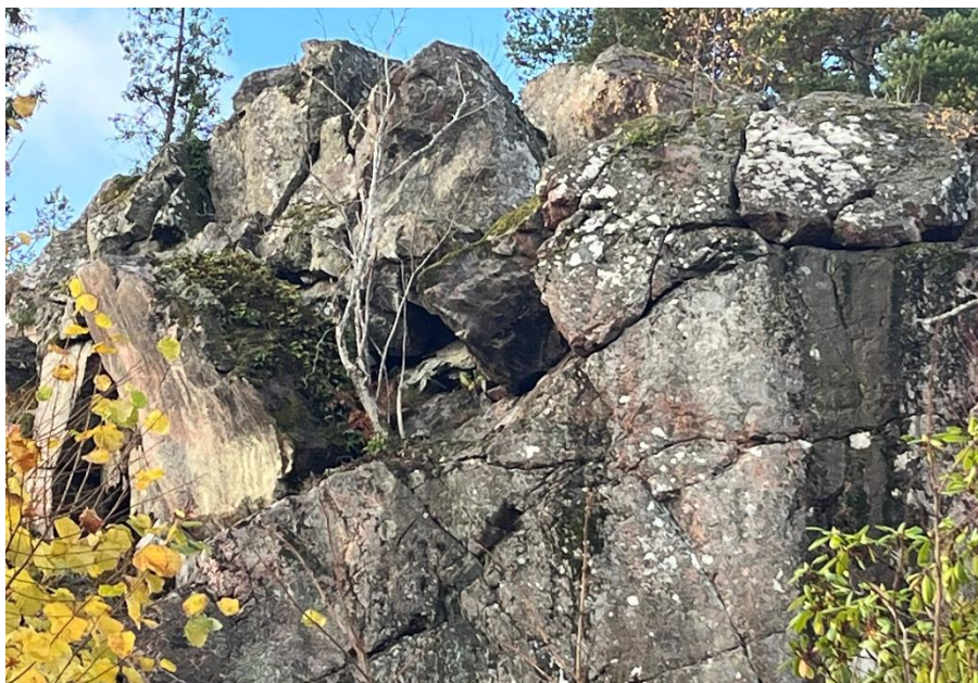
Bild 5: Bergsslänt mellan fastigheterna Vinberga 1:43 & 1:44
