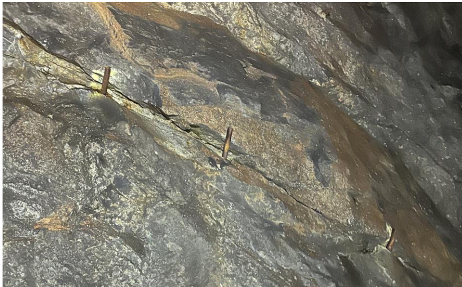
Bild 20: Exempel på förstärkning med bergdubb för att säkra instabila block
