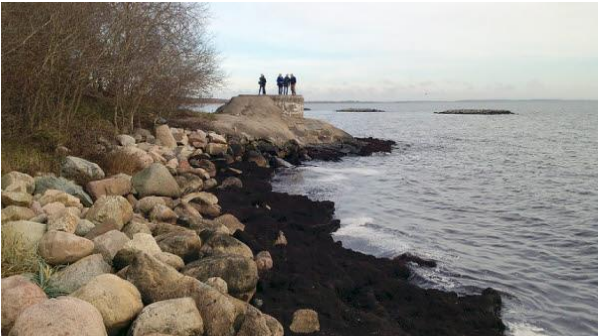
Figur 5. Hårt erosionsskydd med stenskoning ( https://www.sgi.se/sv/vagledning-i-arbetet/stranderosion/fran-inventering-till-atgard/atgarder-for-skydd-mot-stranderosion/for-kuster-och-i-sjoar/ , 2022).
