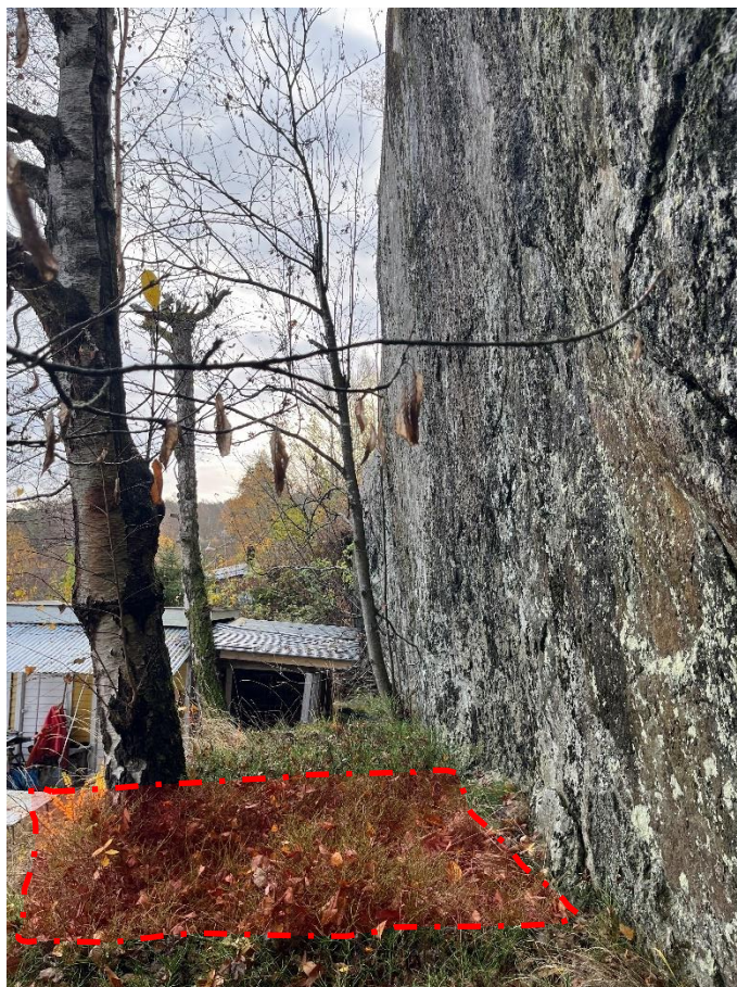
Bild 14: Stabil vertikal slänt invid byggnad Vinberga 1:43
