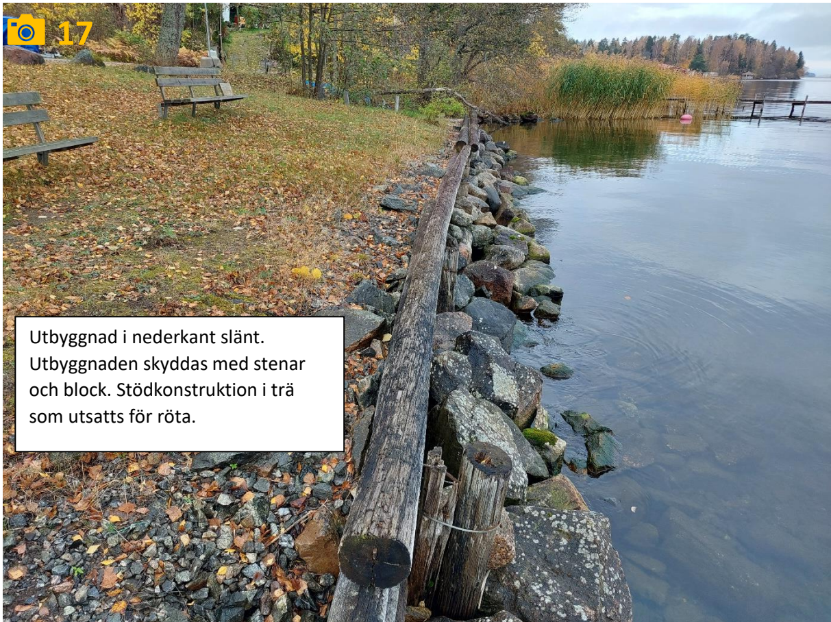
Sandig botten. Utbyggnad av nederkant slänt. Skyddad med stenar och block mot erosion.
