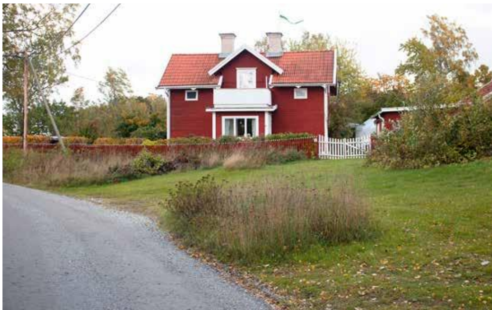
Mälarhyddan, ett nedmonterat hus som ursprungligen stod på Djurgården. Huset blev under sommarmånaderna ett centrum för sommargästerna. Här fanns telefon, radio och affär.
