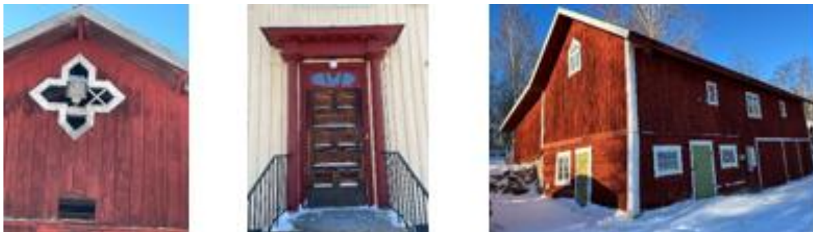
Figur 101 Exempel på fönster och dörrar med höga miljösäkapande värden
