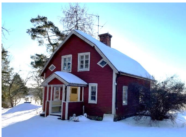
Figur 100 Liggande rombformiga fönster
