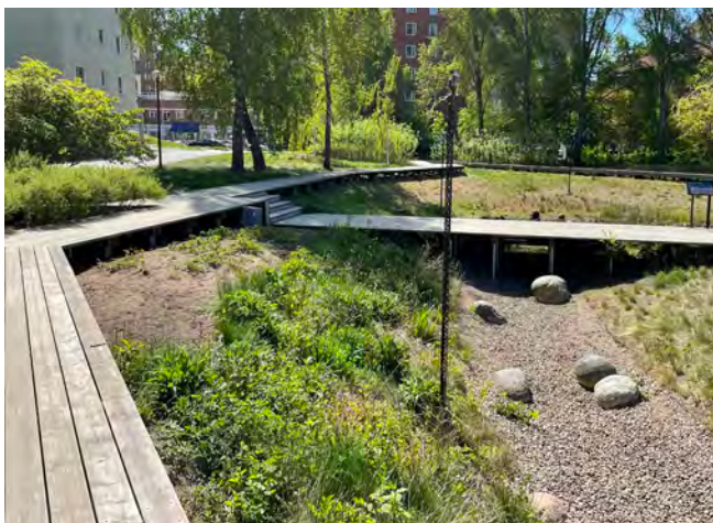
Bilden visar en park med ytor som kan ta emot stora mängder regn.
