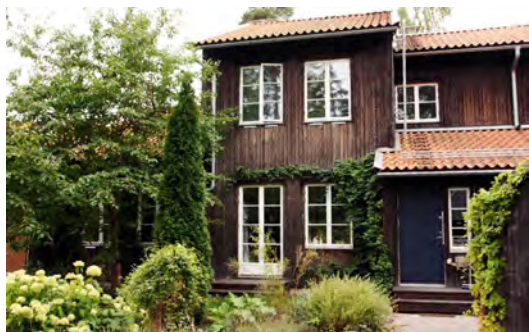
Exempel på träfasad som har fått åldrats naturligt med upp vuxen grönska omkring.
