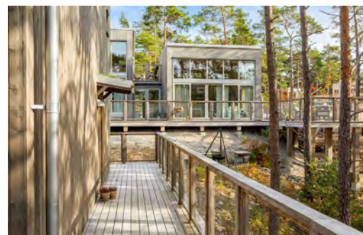
Exempel på utformning av bostäder där marken lutar samt användning av omålade träfasader.
