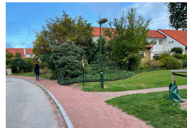
Bilden visar ett exempel på lokalgata där vägbanan är asfalterad och gångbanan är grusad.
