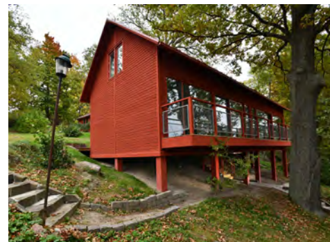
Exempel på hus i sluttning på stolpar.
