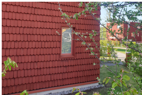
Exempel på detaljerad fasadutformning av rundade träspån.
