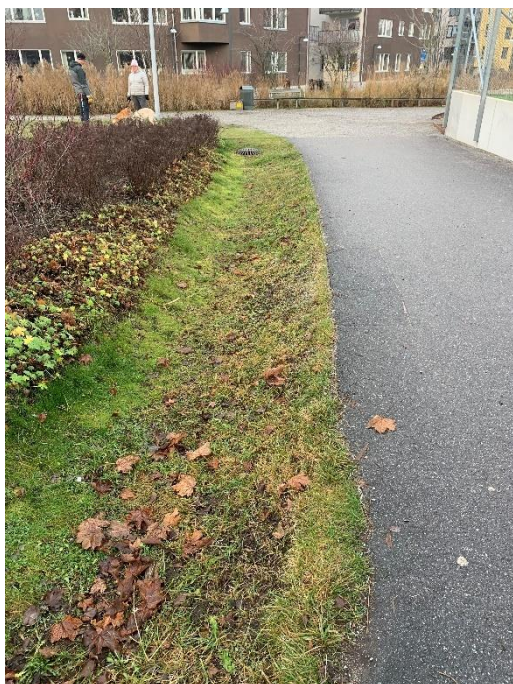
Figur 27 Exempel på utformning av infiltrationsstråk (Foto: Bjerking AB).
