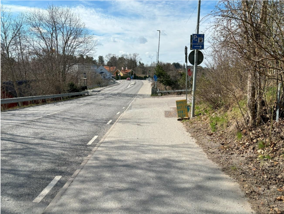
Figur 6 Korsningen väg 57 / Backvägen. Backvägen ansluter i lutning och sikten är delvis begränsad.
