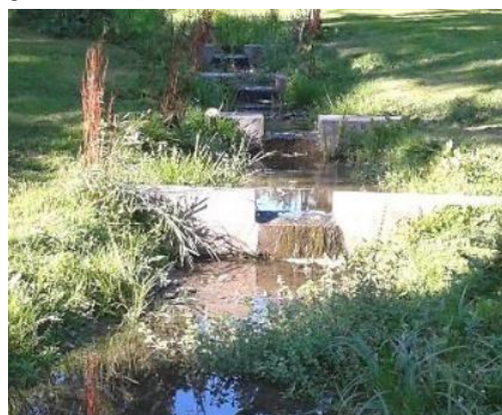
Figur 43 inspirationsbild av sektionerat dike. Källa: Dagvattenutredning, Norconsult, 2024
