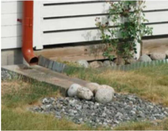
Figur 38. Två alternativ för att avleda takdagvatten till en grönyta.
