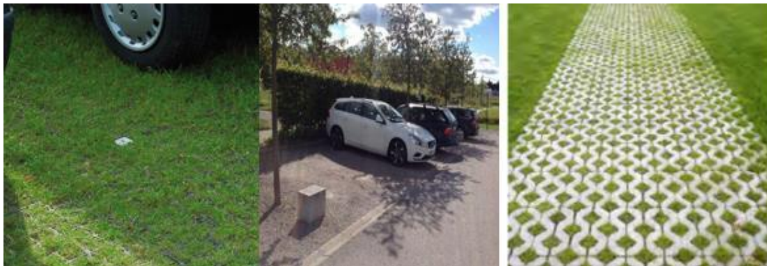
Figur 40. Olika typer av permeabel beläggning på parkeringsytor.
