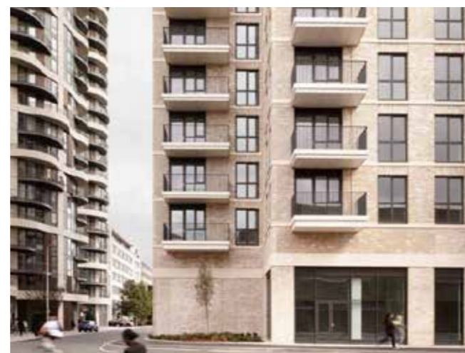
Referens, punkthus: Tegelfasad med förhöjd sockelvåning och välkomnande entrépartier, fasaddetaljering i ljus puts och smidesräcken. Förskjutning av fasadliv skapar vertikalitet. Arkitekt och foto: CJCT Studios.
