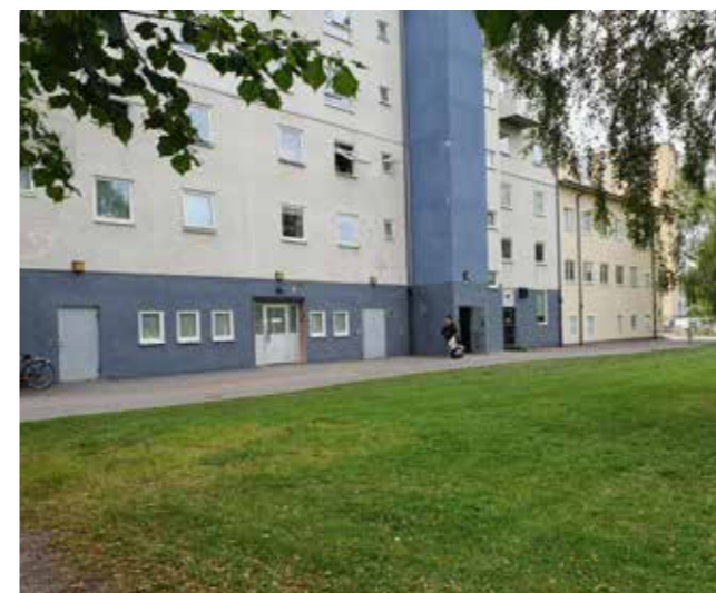
Flera byggnader i Brunnköping har en sockelväning som agerar källarvåning, med bostadskomplement, stängda fasader och diskreta entréer.
