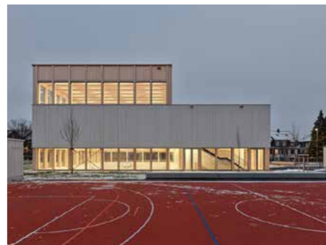
Referens Idrottshall. En samtida gestaltning med öppen sockelvåning och gedigna material skapar trygga och trivsamma gaturum. Arkitekt: kit architects. Foto: Roland Bernath.
