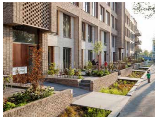
Exempel på småskalig kvartersbebyggelse med entréer, privata förgårdar och dagvattenhantering mot en gemensam gränd. Arkitektur och Foto: Blaw Bureau.
