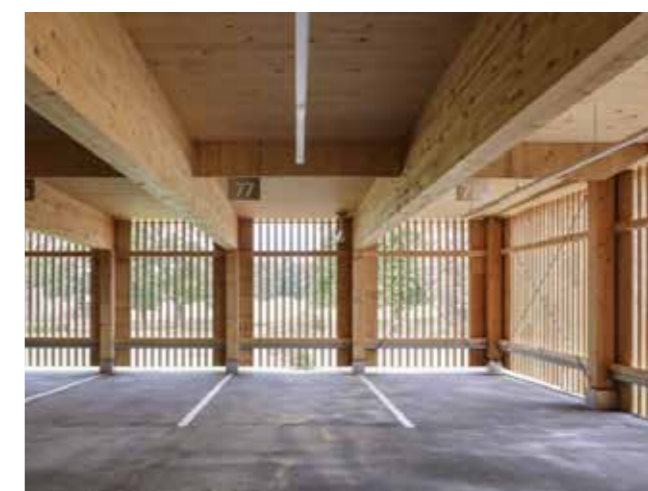
Exempel på mobilitetshus som utformats på ett tryggt och omsorgsfullt sätt med genomsiktliga fasader i trä. HK Arkitekten, Hermann Kaufmann + Partner ZT. Foto: Sebastian Schiels
