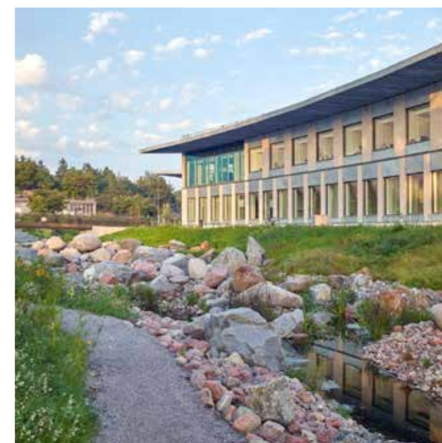
Referens bäckfåra och öppen dagvattenhantering Ett kulverterat vattendrag har lyfts fram till ytan och dagvatten leds till det stenlagda diket på Campus Albano, Stockholm. Arkitekt och foto: Nivå landskap
