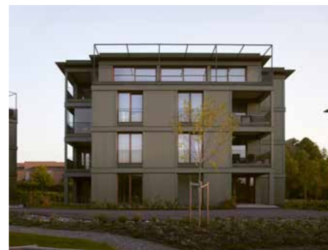
Referensbild, kv Mungon: Indrag av balkong och övre våning bryter ner skalan. Fristående placering i landskapet, enkel fönstersättning och omsorgsfull detaljering gör att byggnaden skapar mellanskala som går anpassa till villabebyggelsen i kvarteret. Arkitekt: R21. Foto: Mariela Apollonio
