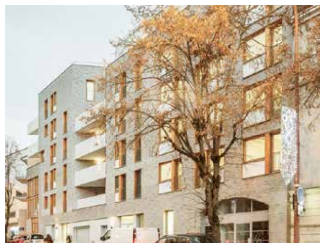
Balkonger utförs generellt som Indragna från fasadliv för att bli mer diskreta i gaturummet. Fasader på indragna balkonger kan utföras i avvikande kulör eller material för att skapa variation i fasaderna och rytmen i gaturummet. Arkitekt: AUP/Architectes. Foto: Archdaily.
