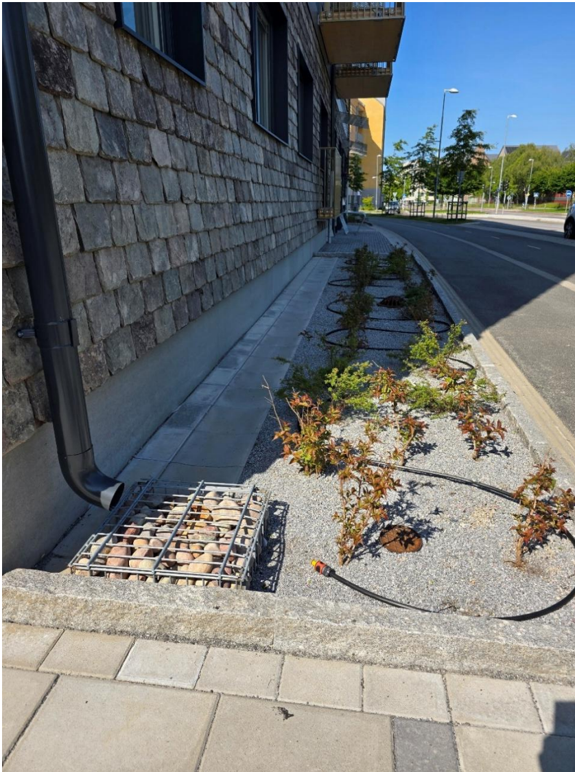
Figur 39. Avledning av dagvatten från tak till regnbädd i Göteborg (Foto: Petter Mogenfelt)
