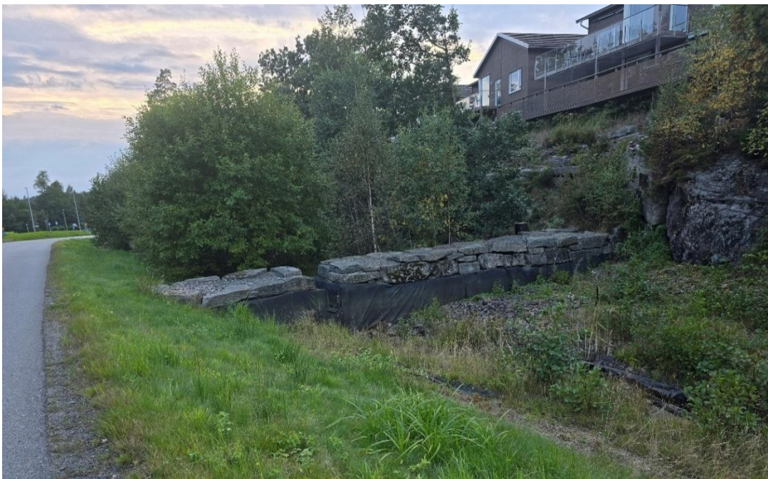
Figur 45. Stenvall i Göteborg, för fördröjning av höga flöden i dike (Foto: Petter Mogenfelt)
