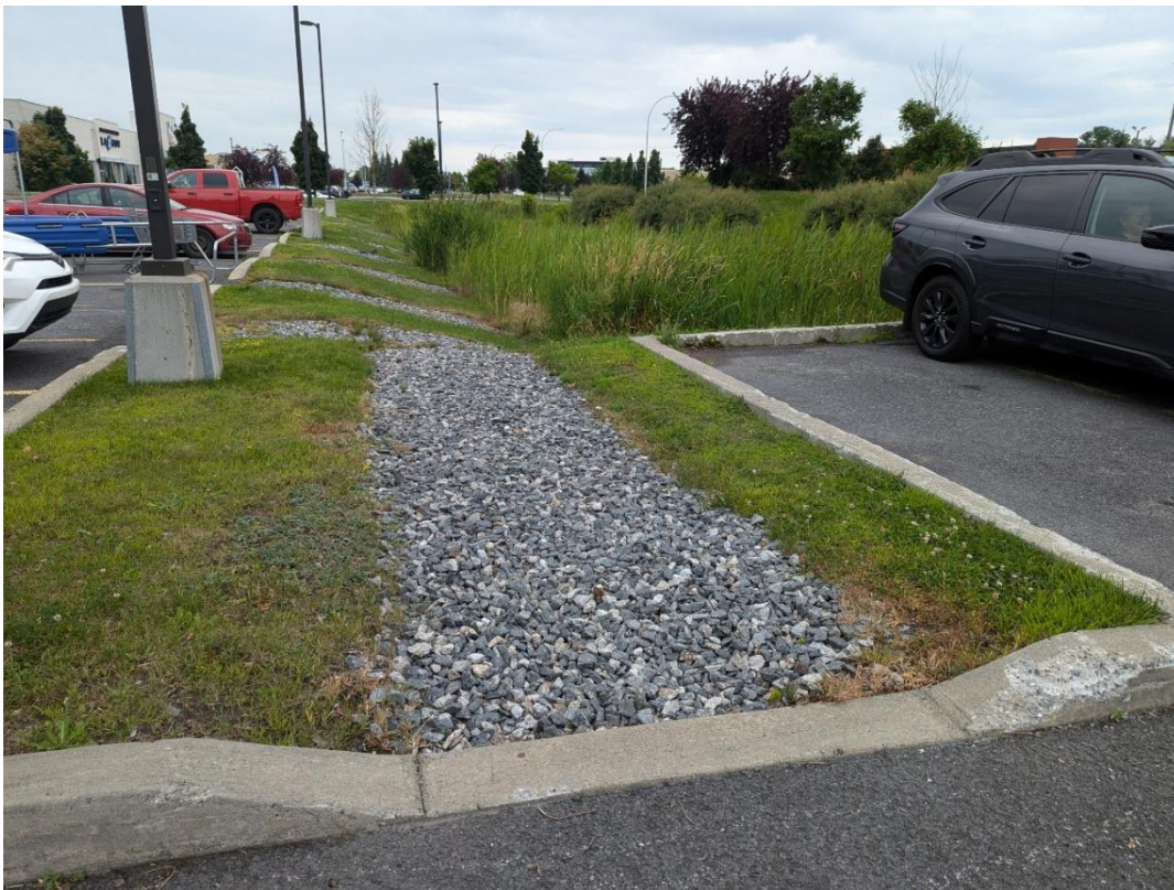
Figur 38. Nedsänkt växtbädd med ytlig tillrinning från parkering i Montreal (Foto: Petter Mogenfelt)
