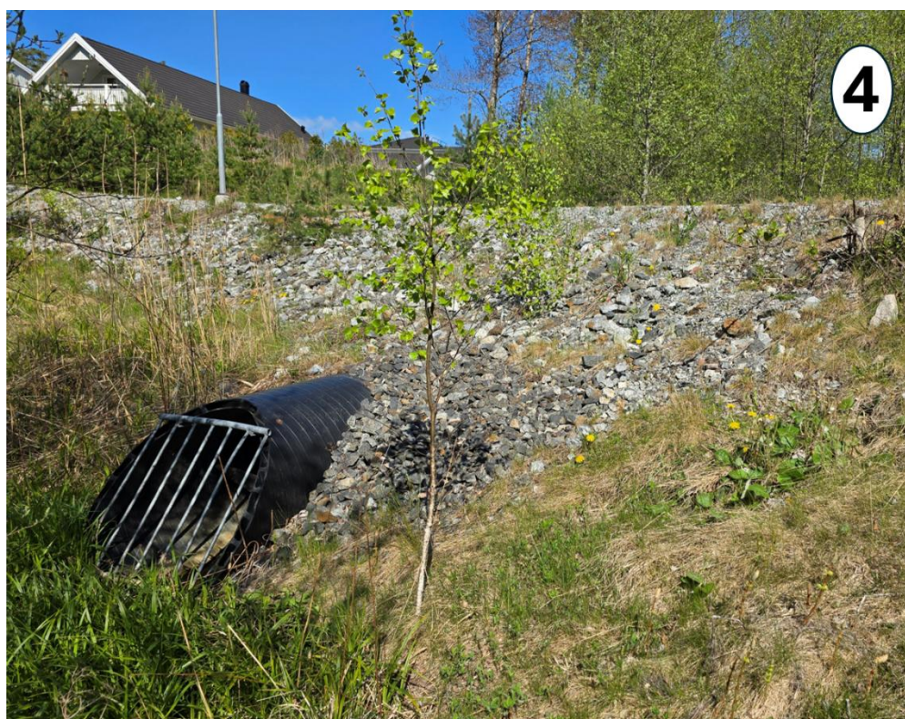
Figur 20. Dagvattenkylvert under gång- och cykelväg i den sydöstra delen av utredningsområdet, platsbesök 2025-05-15 (Foto: Petter Mogenfelt)
