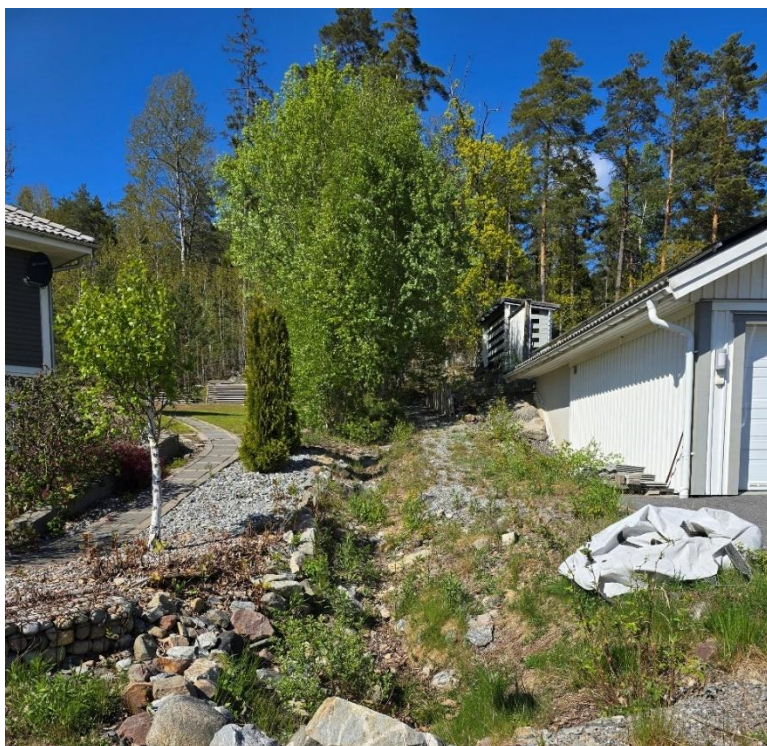
Figur 42. Exempelbild avledning dagvatten/skyfall mellan två fastigheter, Södertälje (Foto: Petter Mogenfelt)
