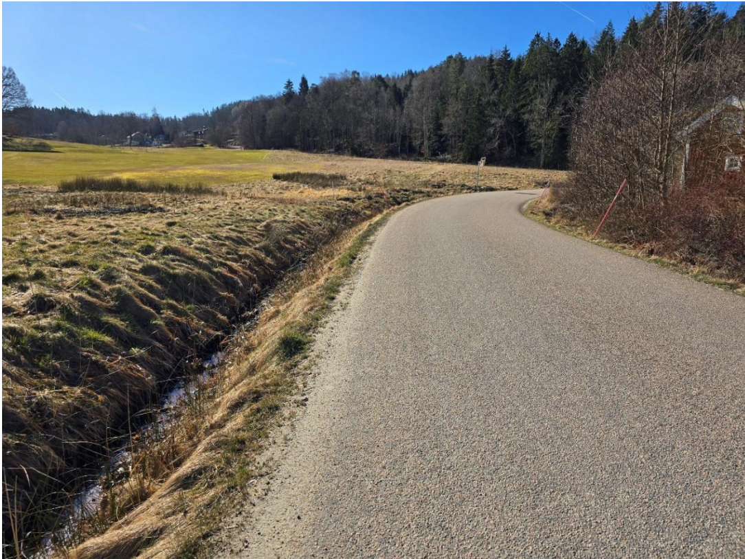
Figur 40. Exempelbild V-format gräsdike, Ljungskile (Foto: Petter Mogenfelt)
