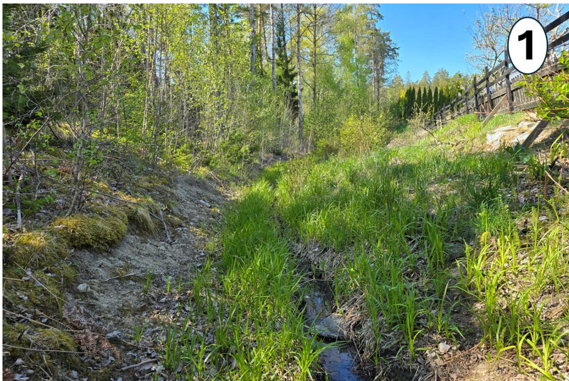
Figur 22. Dike väster om fastigheten Libellen 22, platsbesök 2025-05-15 (Foto: Petter Mogenfelt)
