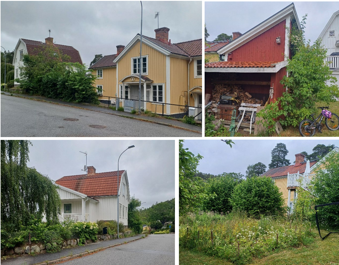
Figur 6 Båda byggnaderna på Fagotten 4 och 5 har kulturhistoriska värden. Byggnaden på Fagotten 5 (den gula byggnaden) har synnerligen höga kulturhistoriska värden. Även omgivande tomt med uppväxta träd, äldre murar och uthus igår i kulturmiljön.
