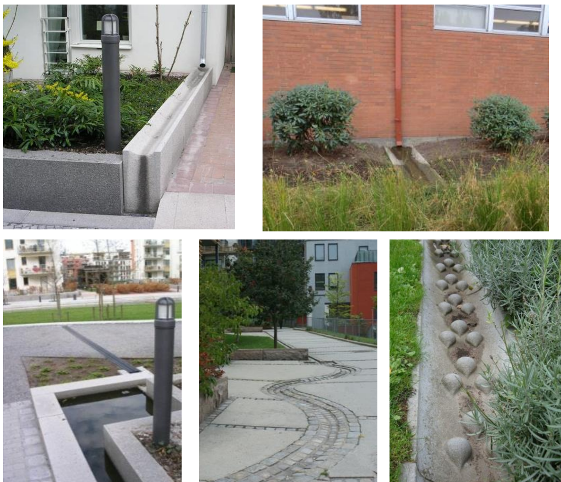
Figur 2. Övre bilderna ger exempel på stuprörutkastare som ansluter till rännor. Nedre bilderna visar olika typer av rännor.
