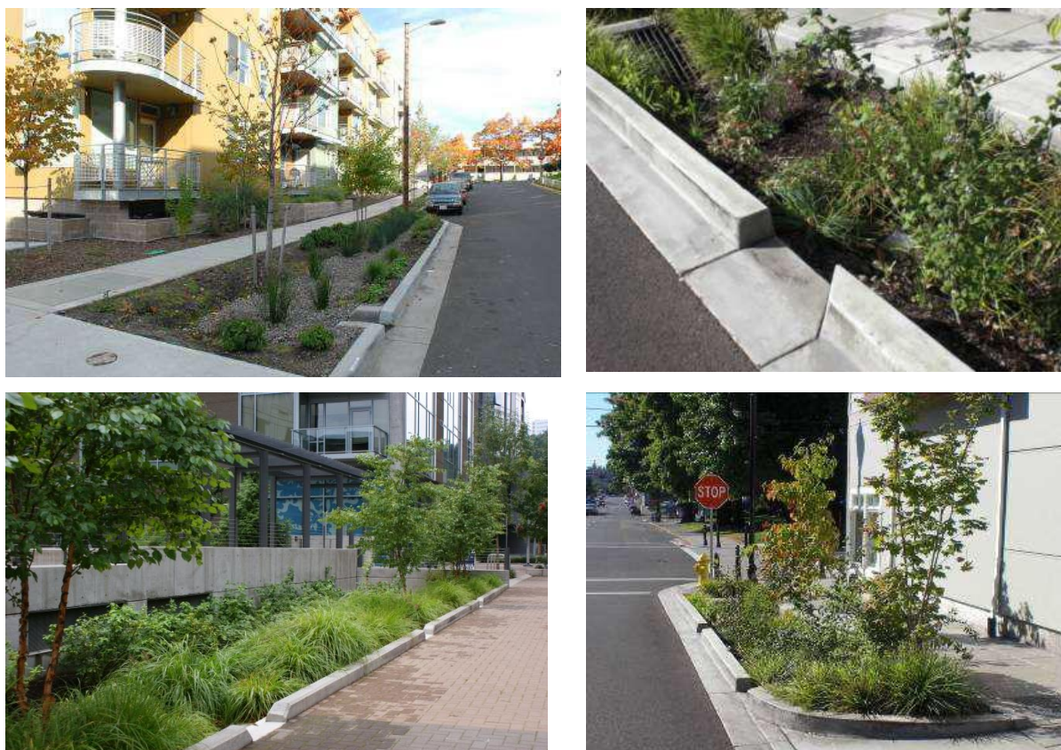
Figur 5. I bilderna visas att övergången mellan gångbana och växtbädd kan skapas utan kantsten och att kantsten med släpp anläggs i övergången mellan väg och växtbädd.
