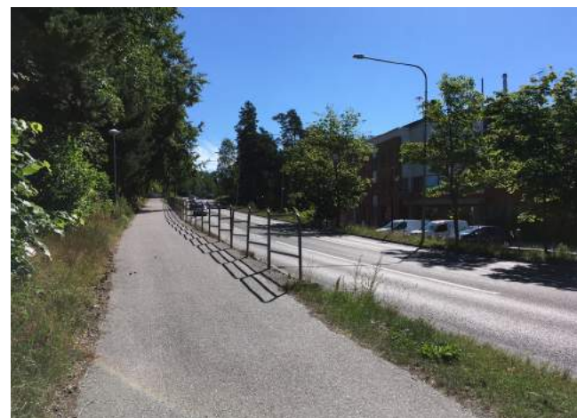
Gång- och cykelväg separerad från bilväg, Holmfastvägen
