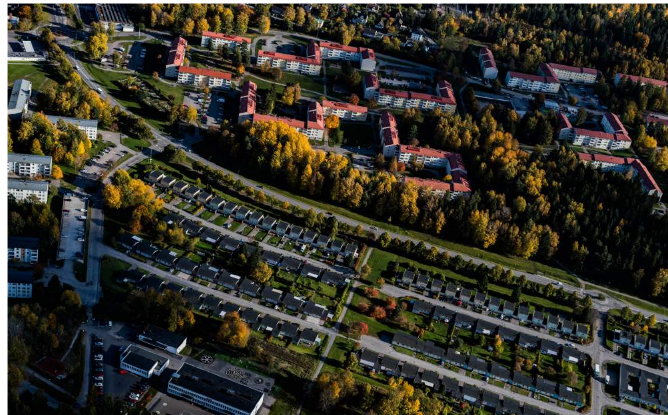
Holmfastvägens karaktär mellan västra Blombacka och Geneta
