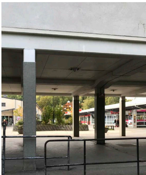
Centrumbebyggelsen sedd från Brunnsängsparken.
