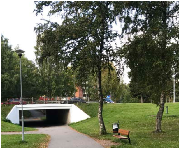
En trafikseparerad tunnel kan upplevas otrygg.
