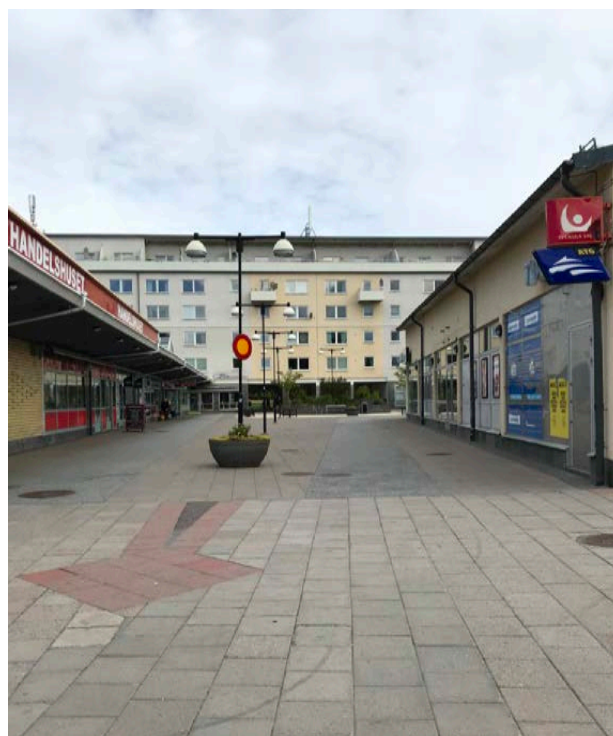
Centrumbebyggelsen sedd från sydväst, ursprungliga byggnader är av tegel.
