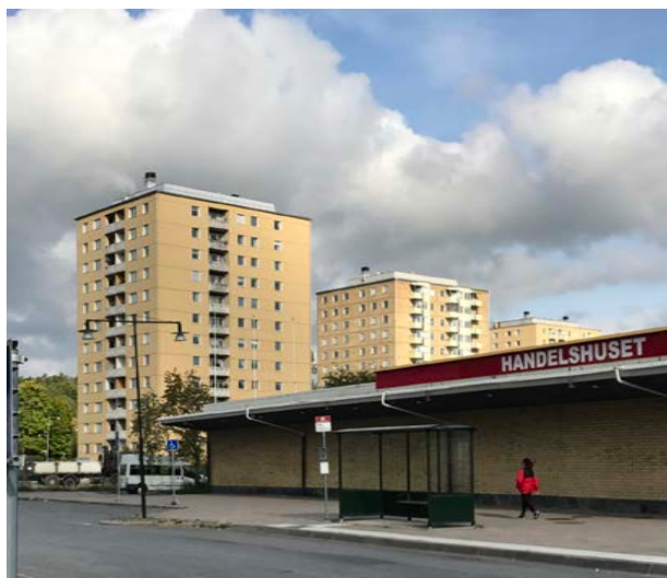
Byggnation av affärscentrum med bland annat butiker och post samt höghusen påbörjades år 1957.
