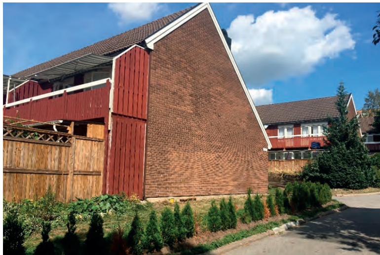
Radhusens branta, asymmetriska sadeltak med slutna gavlar i brunt tegel och rödmålade panel vid balkongerna.
