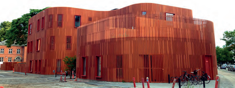
Forfatterhuset barnehage i Köpenhamn är ett exempel på en förskola i mer urban miljö där byggnaden, liksom andra byggnader i staden, förhåller sig till intilliggande gator och tyst gård som skapas på baksidan för lek och aktivitet.
