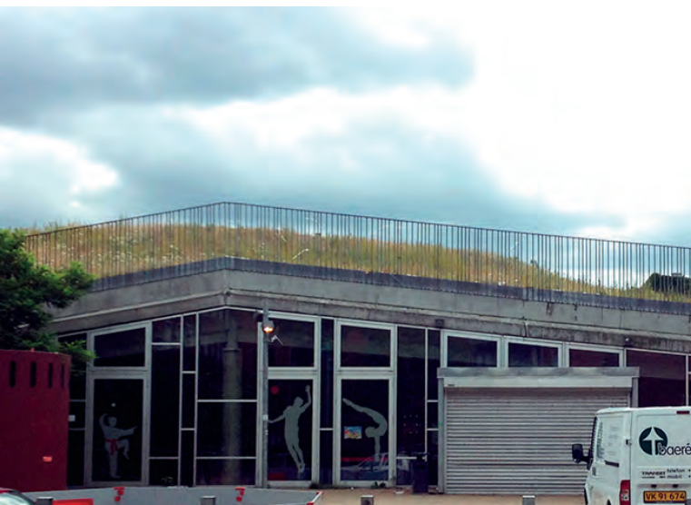
Korsgadehallen i Köpenhamn är ett exempel på hur förtätning också skapat mervärde i form av att byggnadens tak skapar en konstgjord kulle där möjlighet ges för vistelse men framför allt kan stödja pollinatörer.
