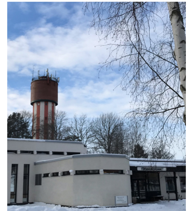
Befintligt vattentorn i Järna är lokaliserat på en höjd ovanför Församlingshemmet.
