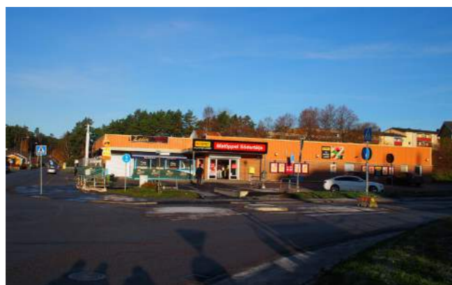
Matöppet/bensinstation korsningen. Foto: Södertälje Kommun.
