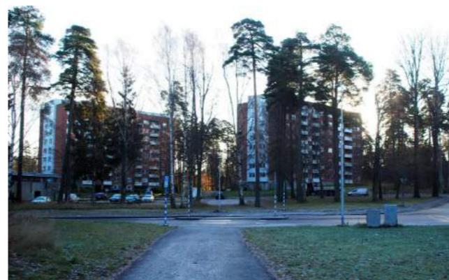
Korsningen Genetaleden/Saltskogsvägen. Foto: Södertälje Kommun.
