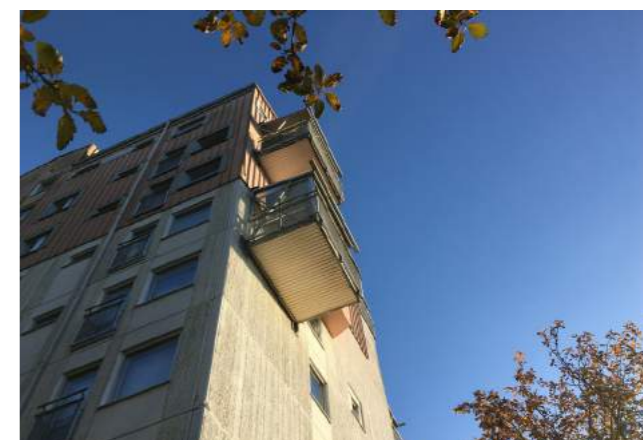
En av 60-talets flerbostadshus som renoverades på 80-talet i Saltskog. Foto: Hanna Becirovic
