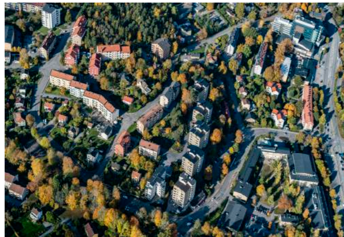
Flygfoto över norra Mariekälla. På flygfotot kan vi se byggnadstypologins varierande karaktär.
