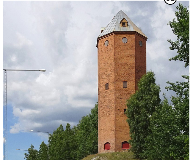
Vattentorn som uppfördes samtidigt som stationshuset Södertälje hamn, ritad av Folke Zettervall.
