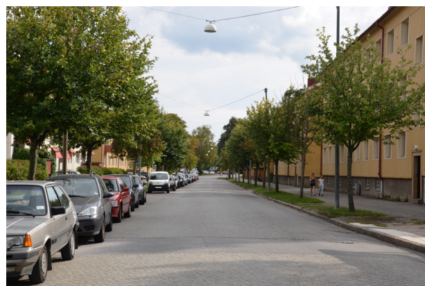
Vägbana på Hertig Carls väg.
