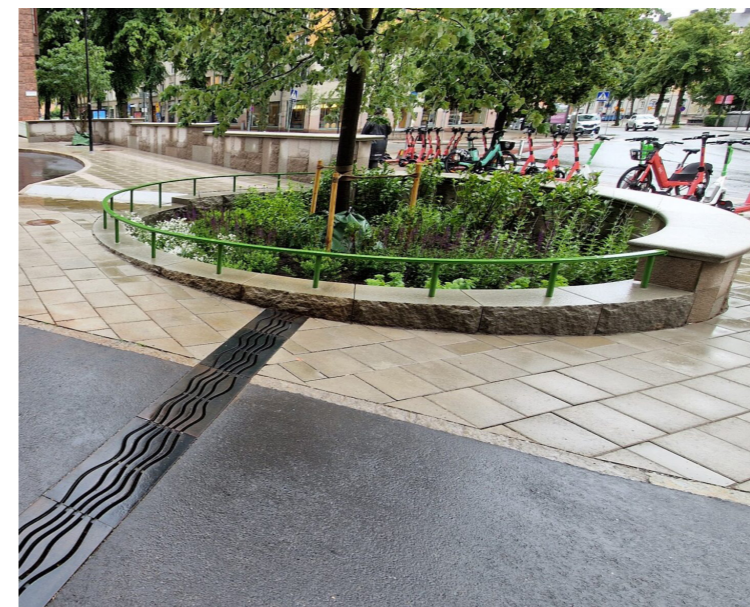
Exempel från Jarlapan i Stockholm på hur dagvatten- och skyfallslösningar kan kombineras med cykelstråk och cykelparkering samt sittplatser. Rännan över cykelvägen leder skyfallsvatten yttill till regnbådden. Utvecklat av Sweco. Foto från Sweco, Stockholm stad .
