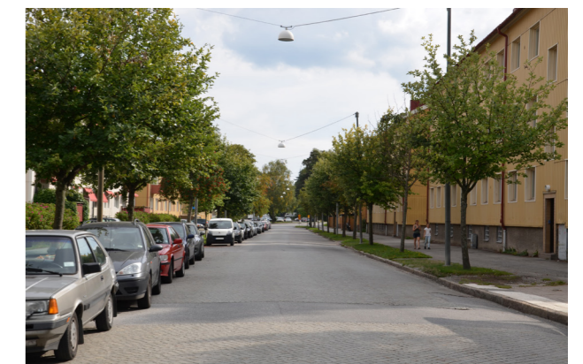
Vägbana på Hertig Carls väg.
