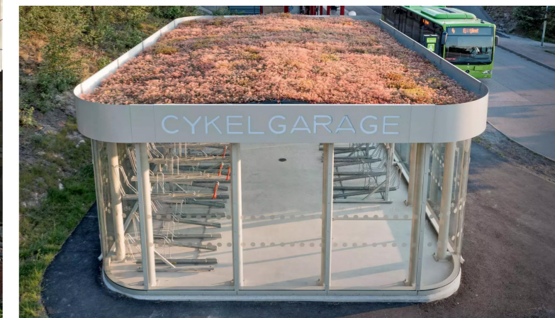
Cykelparkering på Läggesta station i Strängnäs. Exempel på trygg och väderskyddad parkering med infeltrerbart tak för dagvattenhantering. Foto från Cyklos.se .
