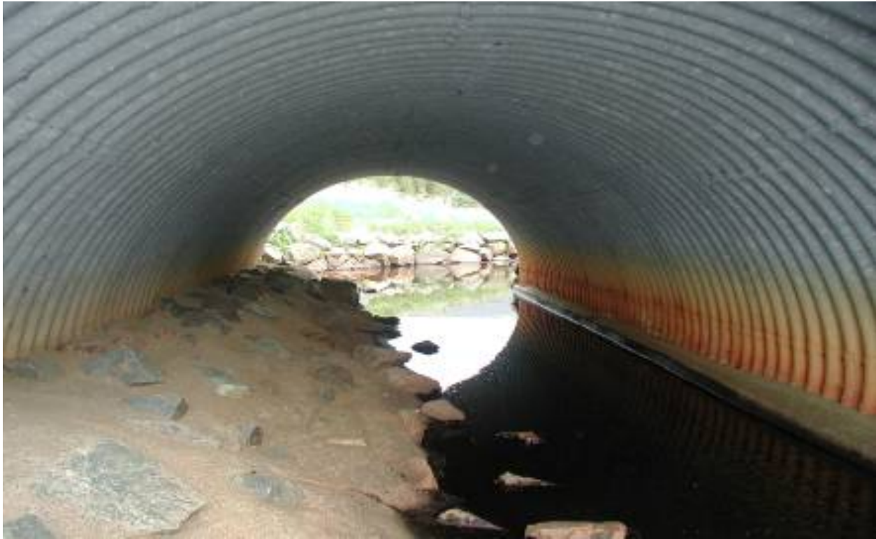
Bild 1. Strandpassage i naturmaterial, byggd i vinkel för att klara olika vattenflöden. Foto: Oskar Norrgrann
