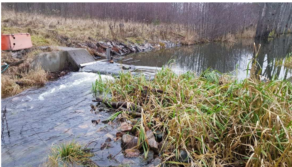
Figur 15. Dämmet som reglerar nivån i Glasbergasjön utgör ett vandringshinder för fisk. Genom att fylla ut med stenmaterial nedanför dämmet kan fallet minskas.
