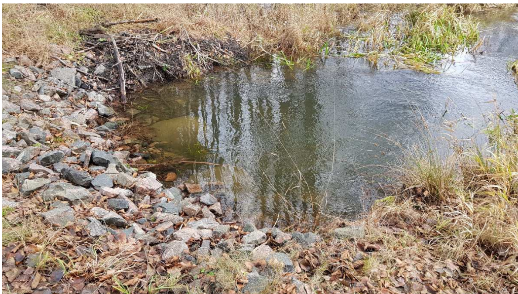
Figur 16. Trummorna i utloppet från Glasbergasjön är små och skapar ett turbulent flöde nedströms. Troligen är flödet i trummorna ett partiellt vandringshinder för fisk. Troligen kan fisk passera vid lågvatten när trycket inte är så stort.
