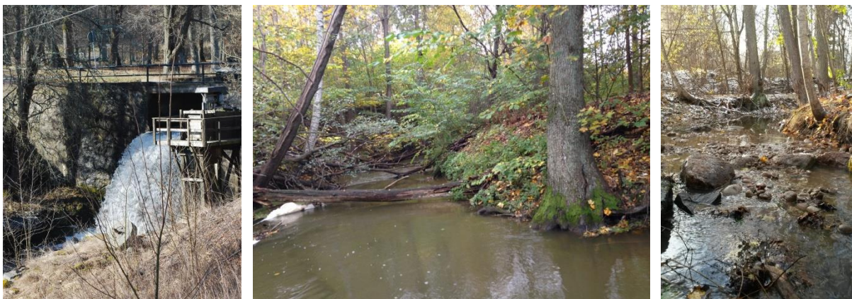
Figur 4. T.v.; Stora dammen vid Bränninge gård, mitten; nyckelbiotoper i Bränningeåns nedre del, t.h. restaurerad forssträcka Bränningeåns nedre del, sträckan restaurerades med storsten och lekgrus hösten 2016. Foto: Carolina Hillerdal, Södertälje kommun.
