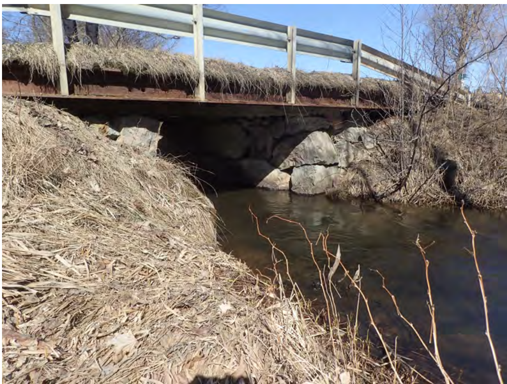
Figur 10. Bron över Kallforsån med sitt stenfundament. Vid anläggande av ny bro föreslås att fundamenten flyttas längre upp på land för att minska bronns påverkan på spridning längs vattnet.
