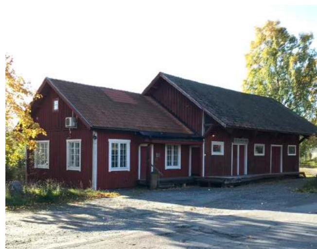
Godsmagasinet vid Norra Järnvägs-gatan.
