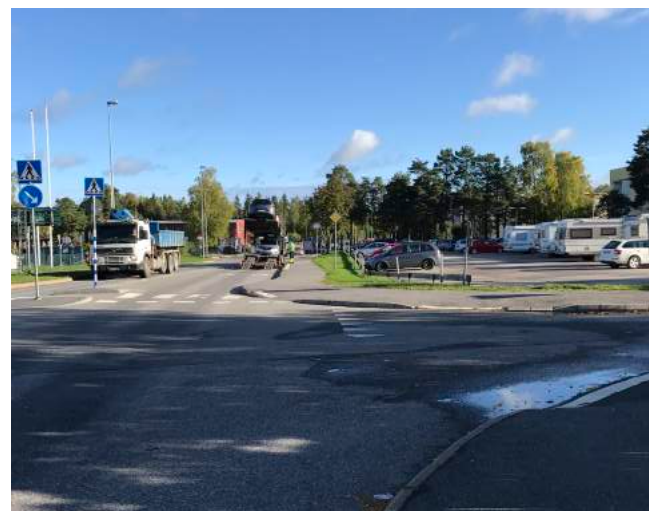
Rönnvägen kantas av parkeringsytor.
