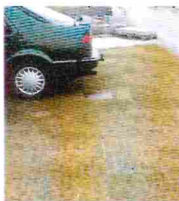
Parkeringsplats med gräsbeklädda pelleplattor
