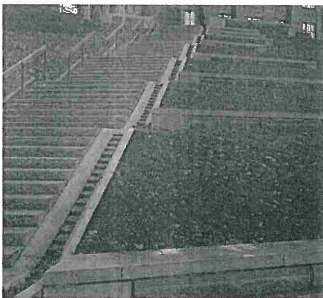
Figur 5. Exempel på dagvattenränna längs med trappa.
