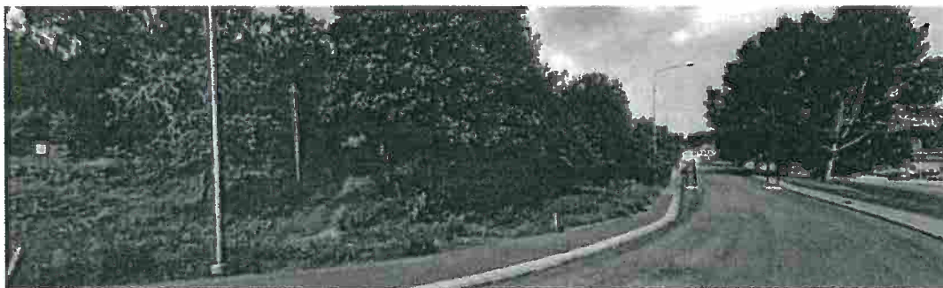
Figur 2. Östergatan foto mot norr, planområdet till vänster i bild.
