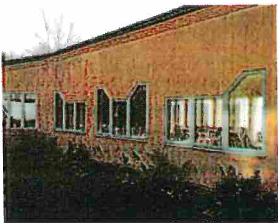
Matsalsfönster mot atrium
