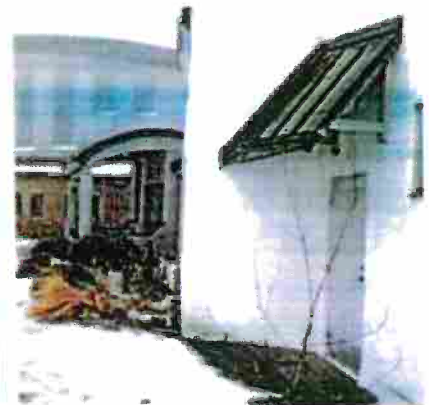
Skärmtak över sidentré
