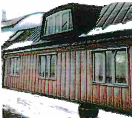
Fönsterdetaljer på västra sidan
