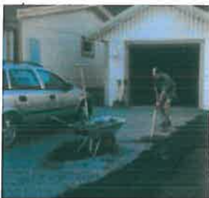
Pelleplattan för gräs- eller grusarmering vilket ger en mycket god infiltration av dagvatten. Bildkälla: VegTech.
