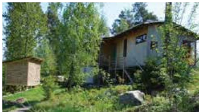
Nybyggnation i Risbro
